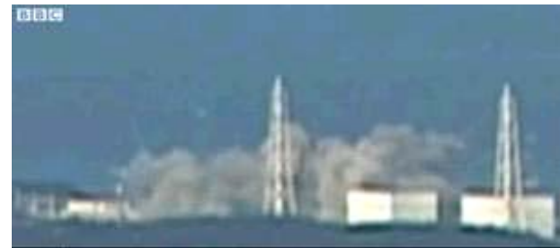
爆発(建屋)する福島第1原子力発電所1号機(BBCより)
